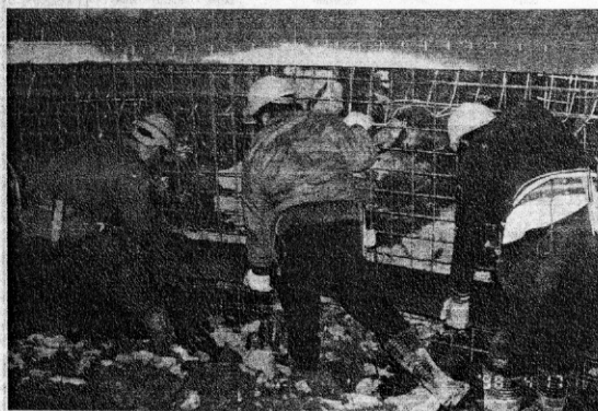
照片七、沉挖工法施工一鋼筋組立
